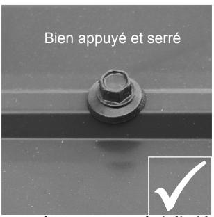
Les vis à toiture peuvent aisément écraser les panneaux de toit et les bordures de toit lors de l'utilisation d'une perceuse électrique. Nous recommandons de serrer à la main les vis de toiture de façon à ce qu'elles soient bien appuyées et serrées contre le matériel de toiture.
